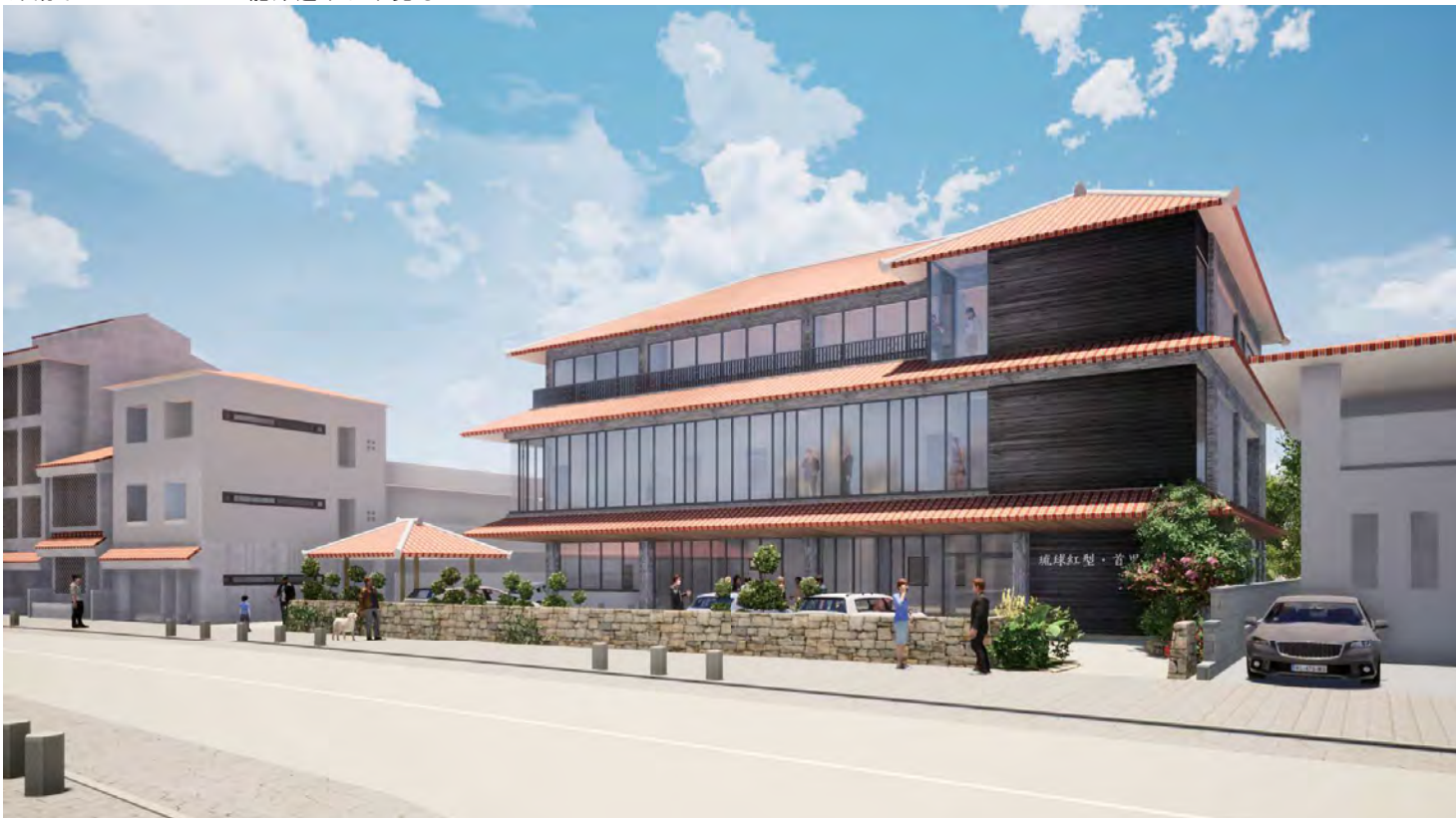
外観イメージパース 龍潭通りより見る
